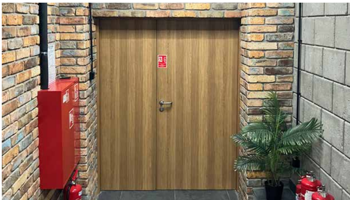
drzwi przeciwpożarowe FR EI30, ościeżnica stała drewniana
